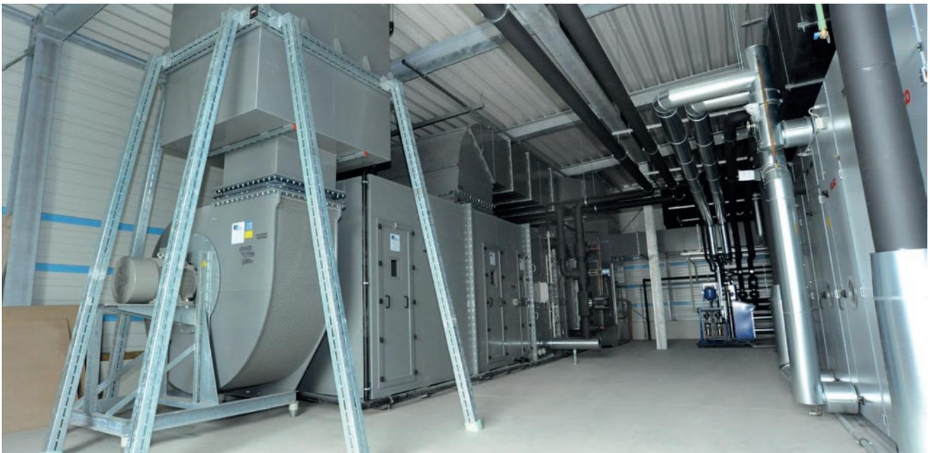
Raumlufttechnische Zentralgeräte von HLU werden aus Kunststoff gefertigt und sind für aggressive Gase mit Volumenströmen zwischen 3.000 m<sup>3</sup>/h und 100.000 m<sup>3</sup>/h ausgelegt. Die hohe Dichtheit und die richtige Wahl der Werkstoffe garantieren ein Höchstmaß an Sicherheit und Langlebigkeit auch unter schwierigsten Einsatzbedingungen.
