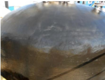
Nach dem gründlichen Anschleifen der GFK-Oberfläche wurde unser Produkt ULTRA PERFORM 2R in 2 dünnen Schichten manuell mittels Rolle und Pinsel aufgebracht. Eine Gesamtschichtstärke von 1000µm reicht aus, um dauerhafte Resistenz gegen die Salzsäure zu erhalten.
